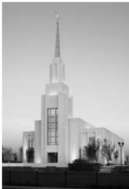
Templet i Twin Falls i Idaho, USA invigdes i augusti 2008.
