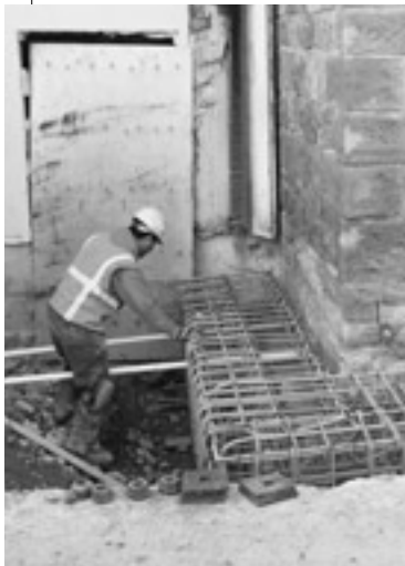
Det förbättrade jordbävningsskyddet gav bland annat en starkt grund.
