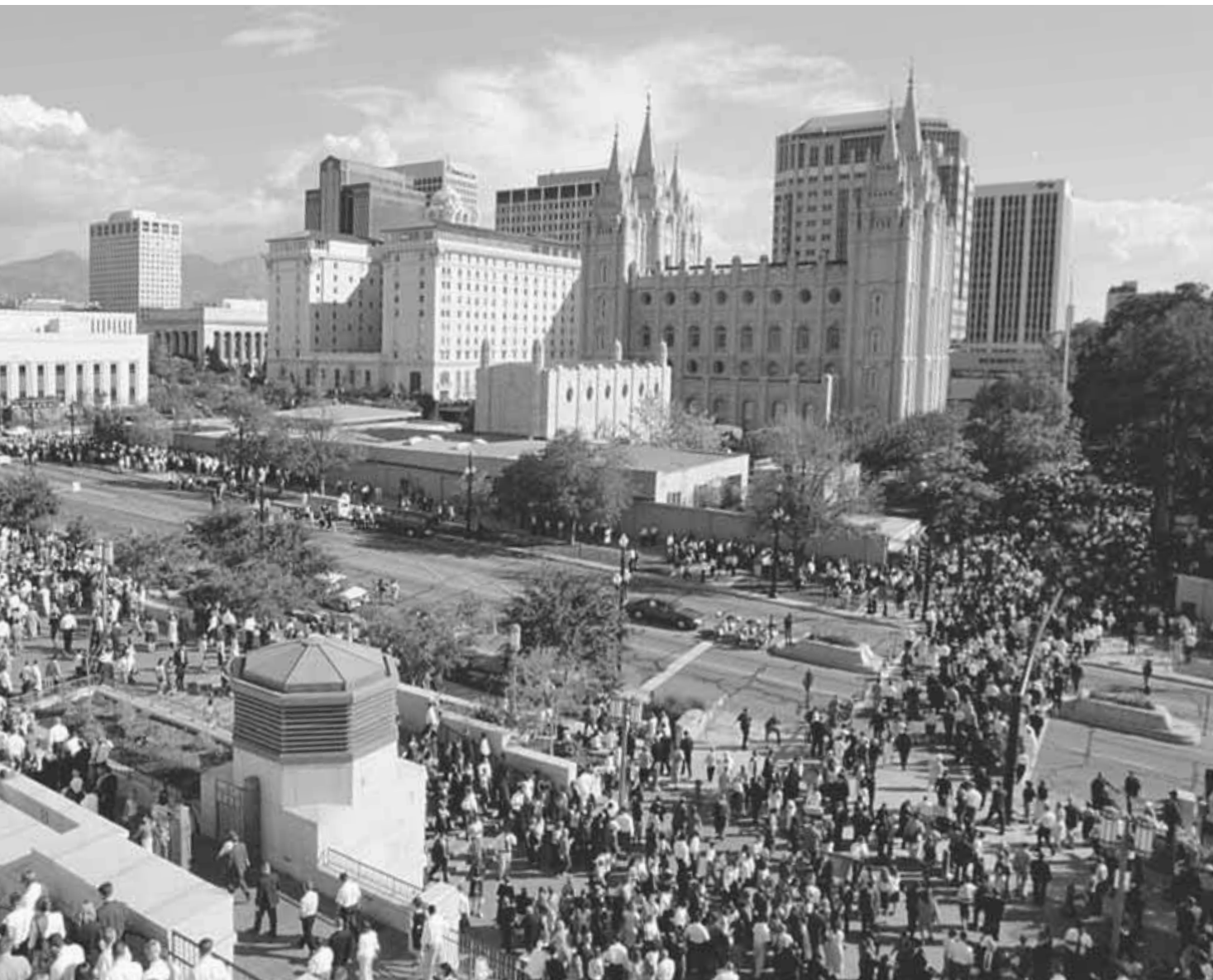
Kyrkans kontorsbyggnad (till vänster), templet (till höger) och byggnader i centrala Salt Lake City dominerar utsikten från konferenscentret.
